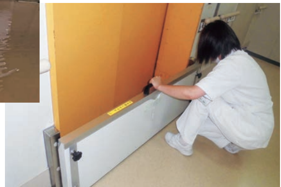
今年導入した止水板を看護師が設置している場面
